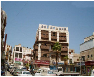
شكل رقم (٩): الطابع المعماري لمنازل مدينة جدة القديمة
