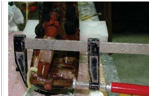
صورة (٨) يوضح طريقة تثبيت الجزء المنفصل باستخدام الملازم الحديدية.
