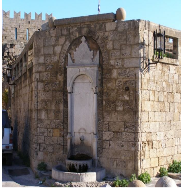
لوحة ٩ : جشمة الترسانة Ceme mevdanindaki tersane by میدان Symi والمبنى الملحقة به بجوار سور المدينة.
