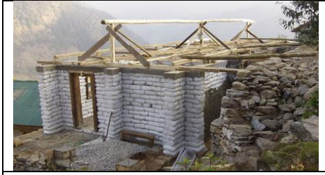
تركيب الجمالون الخشب علي كمرات الربط.
