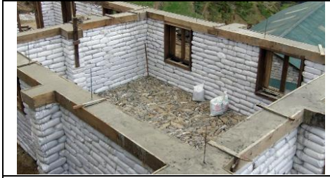
صب الكمرات الخرسانية لربط الحوائط وكذلك الأكتاف.
