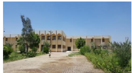
شكل (27) المبنى التعليمي بالمدرسة المصدر : الباحثة 2019
