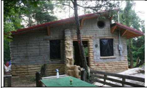
رفرفة الأسقف فوق أكياس التربة لحمايتها من العوامل المناخية المختلفة كالشمس والأمطار.
