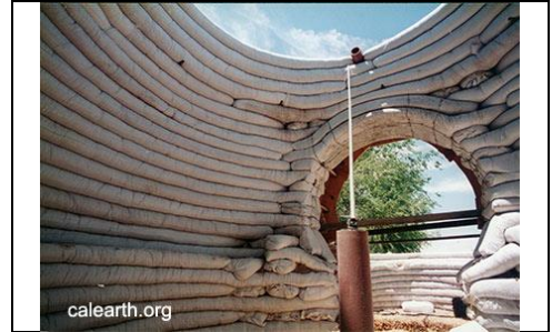
رفرفة صفوف أكياس التربة بحيث تكون القباب،
