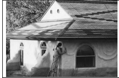
التغطية بألواح الشنجلز الأسفلتية، المصدر: K.Hunter & D.Kiffmeyer, (2004)p109.
