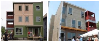
شكل (٢٨) استخدام الالوان الفاتحة المبهجة في الواجهات (١٥)
